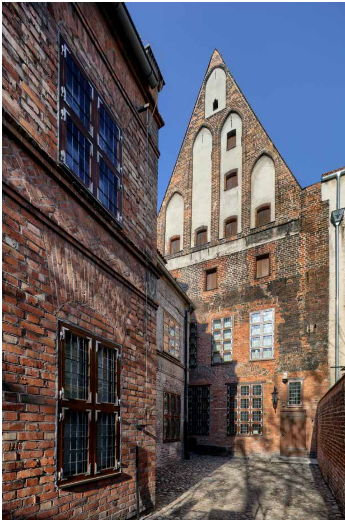
Fot. 2. Widok fasady tylnej Domu Mikołaja Kopernika | fot. A. Skowroński
