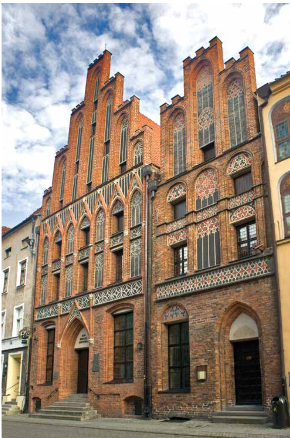
Fot. 1. Dom Mikołaja Kopernika – kamienice przy ul. Kopernika 15 i 17 | fot. K. Deczyński
