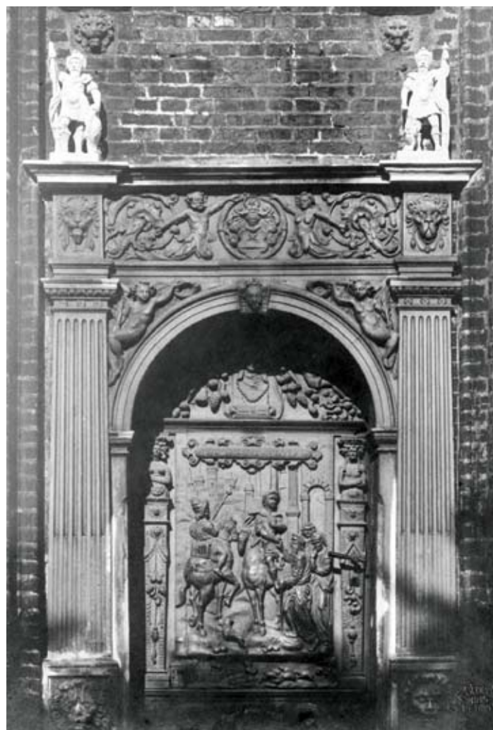
5. Portal i drzwi kamienicy przy ul. Łaziennej 16 w Toruniu, przed 1601
