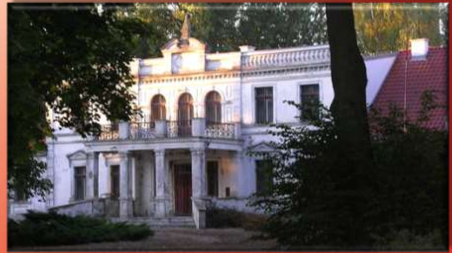
Pałac w Wałyczu, stan obecny.
