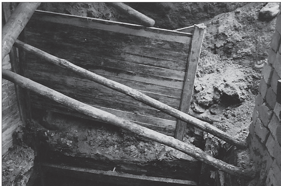
Fot. 3 Szambo u. Podmurna 53 (fot. Andrzej Kola)
