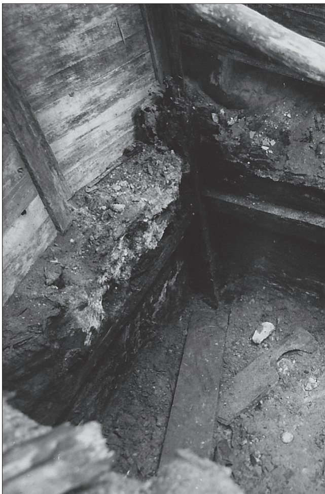
Fot. 2 Szambo – ul. Podmurna 53 (fot. Andrzej Kola) [Źródło: A. Kola, Sprawozdanie, nr inw. 1/90]
